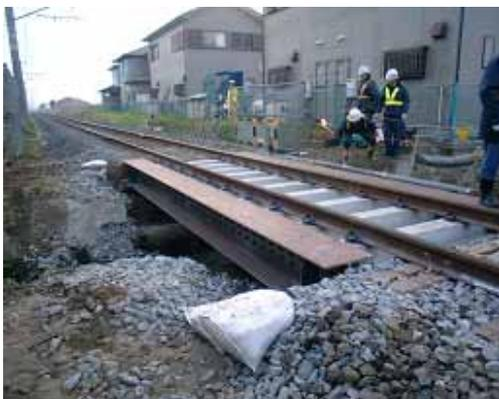
写真-1 工事桁の使用状況
