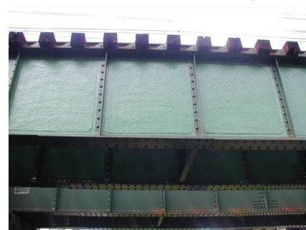
写真3 トップコート塗布完了後
