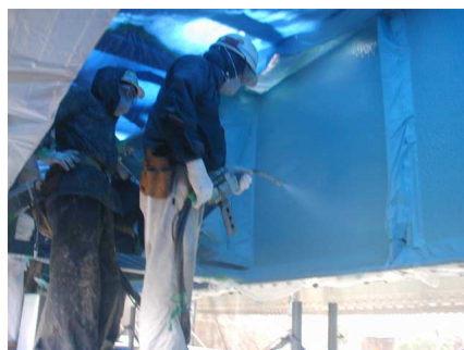
写真2 UU樹脂吹付け状況
