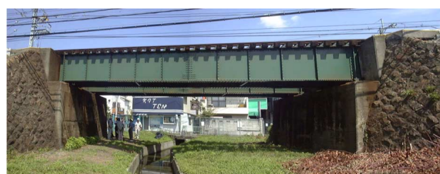
写真1 対象構造物（UU樹脂塗布前）
