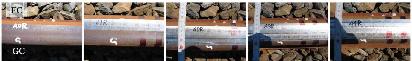
図 - 1 削正前 図 - 2 1 パス後 図 - 3 2 パス後 図 - 4 3 パス後 図 - 5 4 パス後
