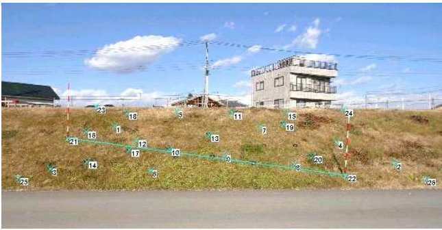
図 4. 法面解析状況
