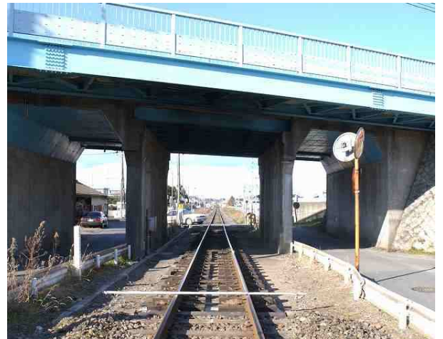
図 6. 跨線道路橋に対する建築限界測定
