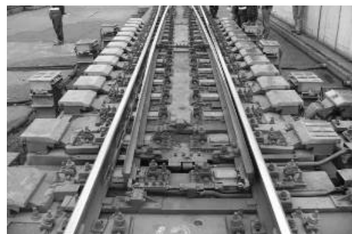
図 1 電気温風式融雪器
