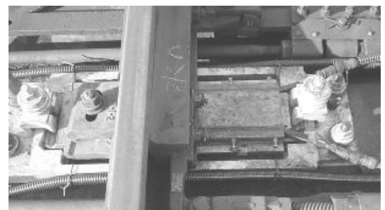
図3 SSS形融雪器と改良横圧受装置
