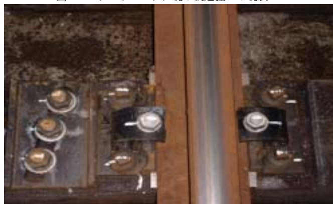
図3 橋まくらぎ用調節形レール締結装置
