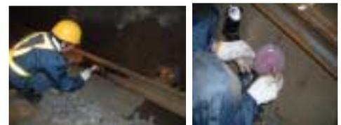
写真.2 レール防食加工の現地施工例（ロングレール取卸箇所）
