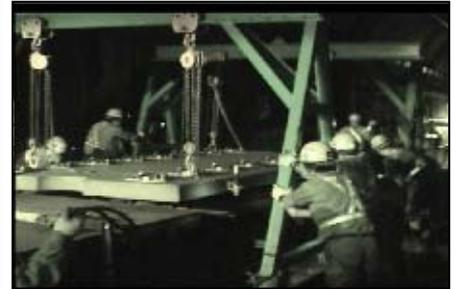
写真2 大門形クレーンによる吊り上げ
