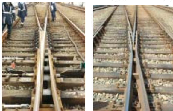
写真1: 施工前(左)と施工後(右)
