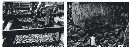
写真-3 54kgランマー転圧 写真-4 つき固め後
