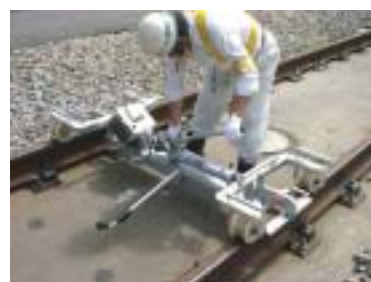
写真-3 簡易通り整正器
