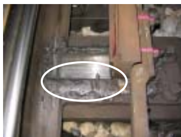
図 1 床板の段付き摩耗
