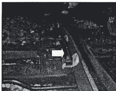
写真-4 ボルト型アンチクリーパー
