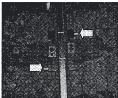
写真-4 ボルト型アンチクリーパー
