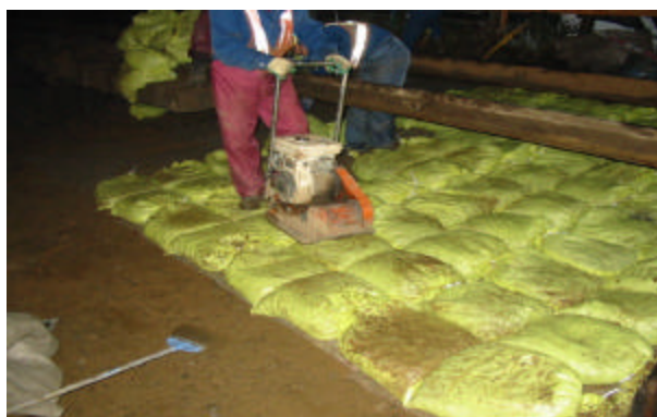
写真-1 「土のう」の転圧作業
