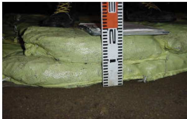
写真-2 「土のう」の転圧後の状態
