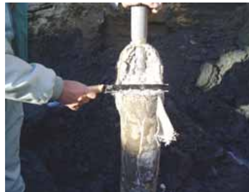
写真 1 ジオバッグ充填状況
