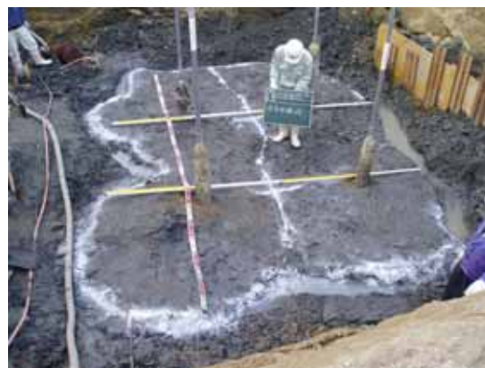
写真 2 エキスパッカ工法の改良体
