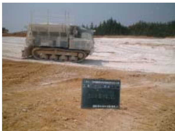
写真-1 生石灰散布状況（スプレッダ）
