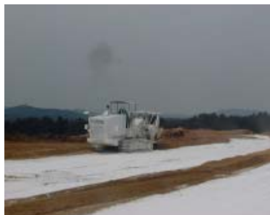
写真-2 混合・攪拌状況
