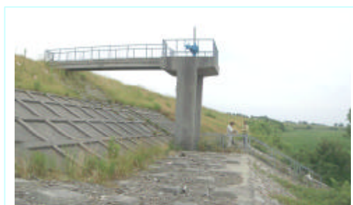
写真-1 排水樋管の例（阿賀野川）
