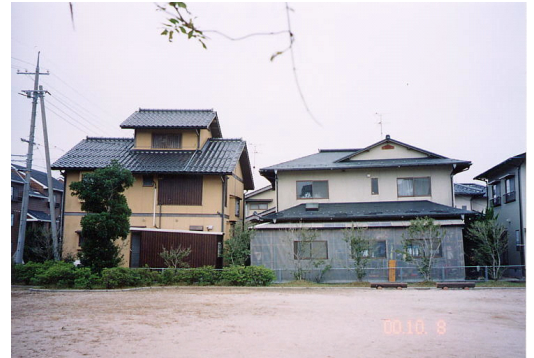
写真-1 液状化により不同沈下した家屋(安倍彦名団地)
