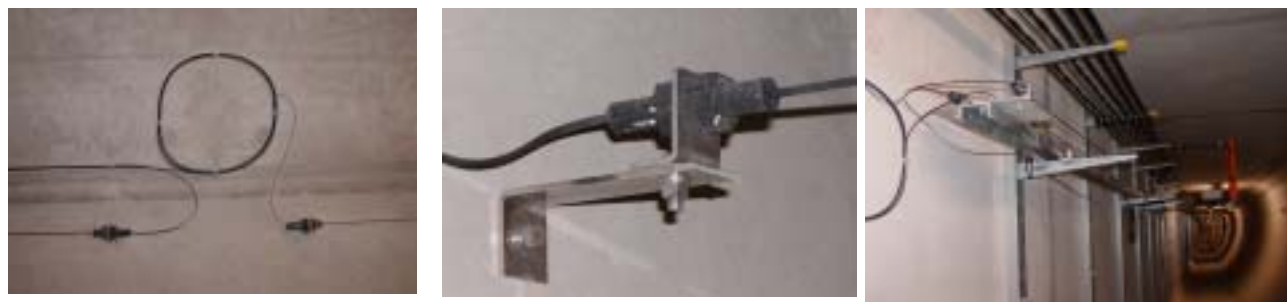
図4 センサ設置状況
