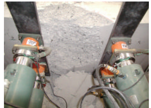
写真 - 4 再載荷最終状態 2 （90° 覆工外面）
