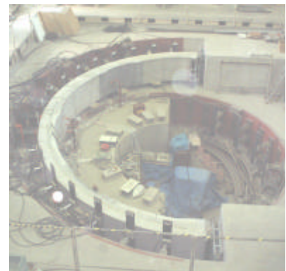
写真-1 載荷実験状況
