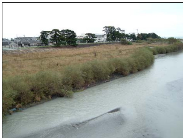
写真-1 安倍川左岸のヤナギ群落（河口より 0.75 km）
