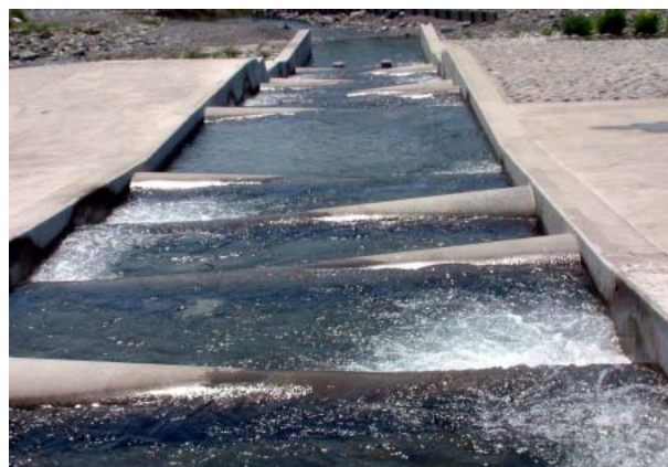
写真1 ハーフコーン型魚道（多摩川羽村堰）
