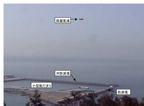
写真—2 港全景（新港）
