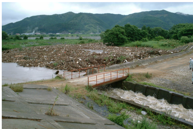
写真-1 流木及び塵芥の集積状況 (筑波洗堰 平成13年8月)
