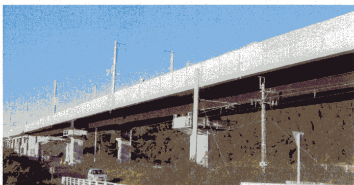
図1. 九州新幹線松尾線路橋写真
