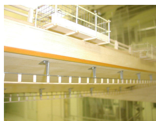
①架設足場
