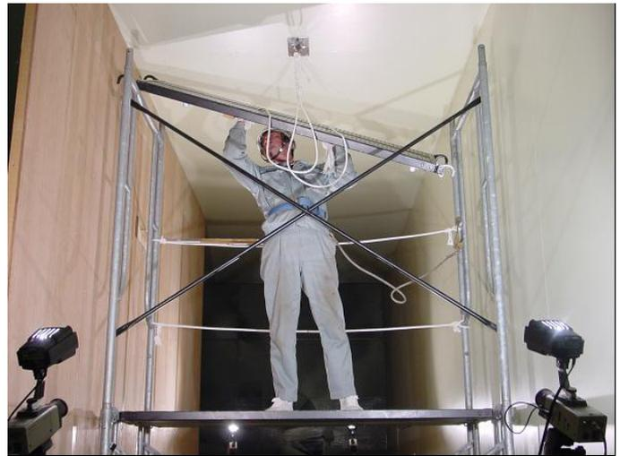
写真1 床付き布枠の取り付け・取り外し作業
