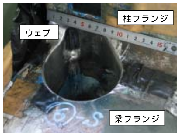
写真3 スカラップ法（板組 WW）
