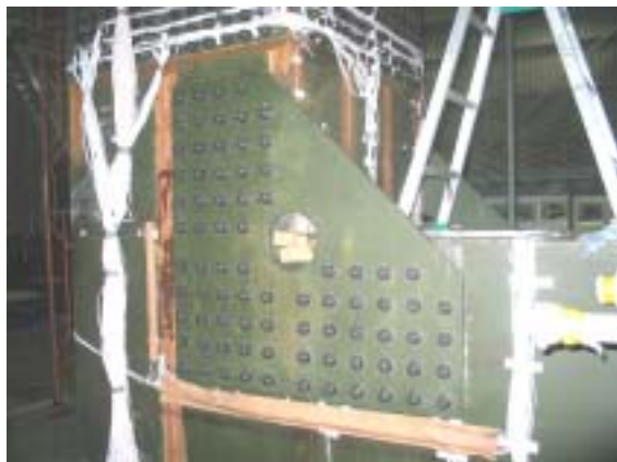
写真2 当て板ボルト補強
