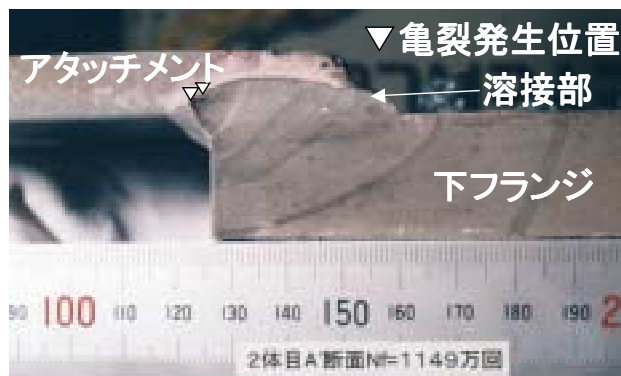
写真-1 疲労破面
