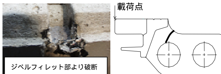
図5 階段状漸増載荷実験の破断状況
