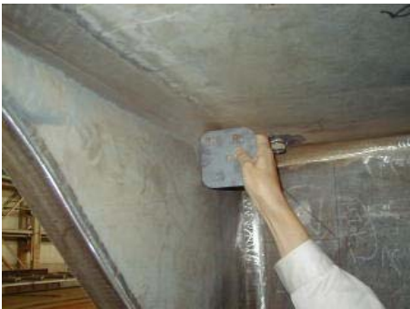
図-5 フィレット内側の仕上げ状況
