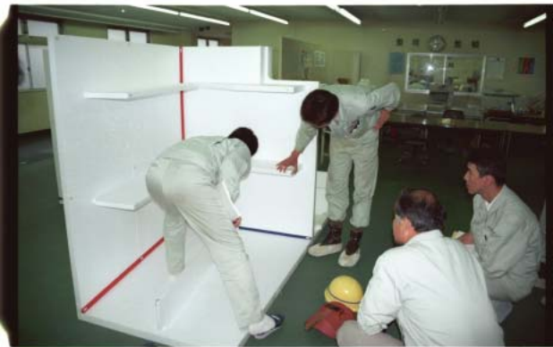
図-6 実物大模型による溶接作業性の確認
