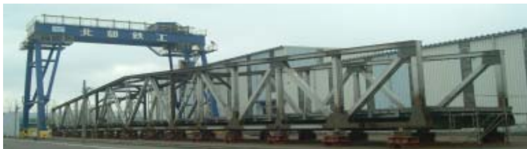
写真-3 製作工場での仮組中の再生トラス橋
