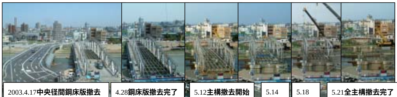
写真-2 解体中の御影大橋
