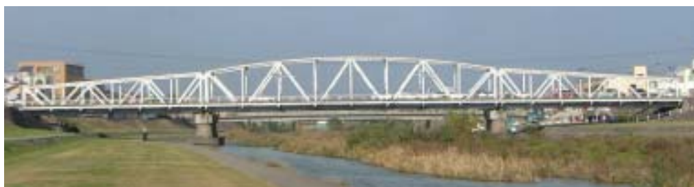
写真-1 解体される前の御影大橋
