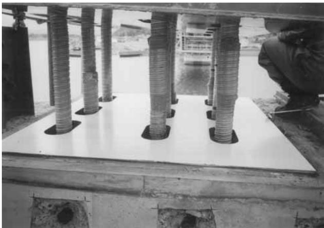
写真 - 1 テフロン板を用いた滑り板
