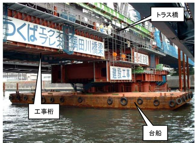
写真-1 工事桁降下
