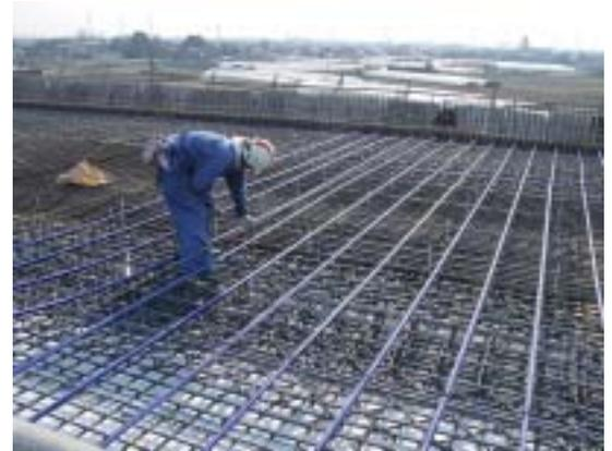
図-1 場所打ち PC 床版施工状況
