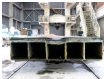
写真-3 支間中央部切断面
