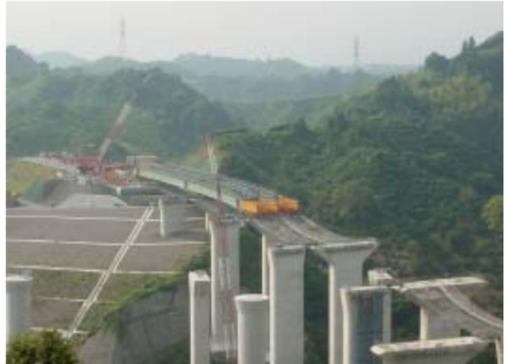
図-1 伊佐布1号高架橋送出し架設全景
