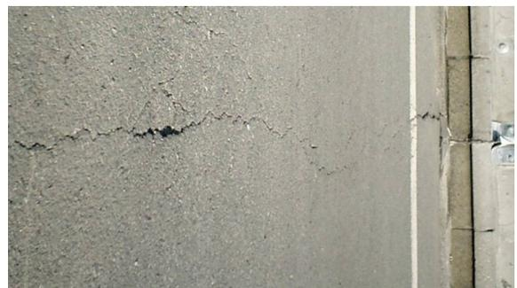
図-2 ノージョイントの損傷例（現行基準）
