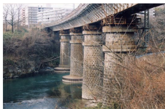
写真-1 補強前の石積み橋脚
