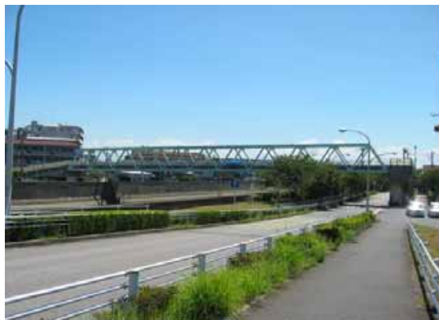
写真 1 見明川歩道橋
