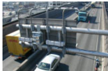
図４ TMD の設置状況
