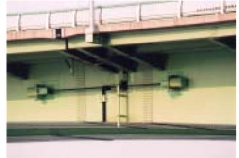
写真-2 3DSole 弾性連結装置
