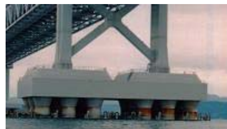
写真－1 3P主塔多柱基礎
