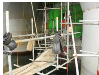
写真-3 多柱基礎補修工事状況
