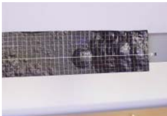
図5 撮影した腐食鋼板
