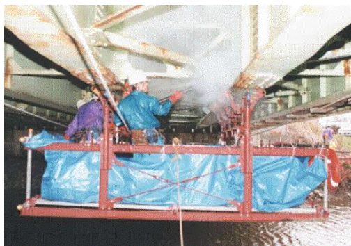
a) 簡易移動吊足場を用いた洗浄 (北海道)
