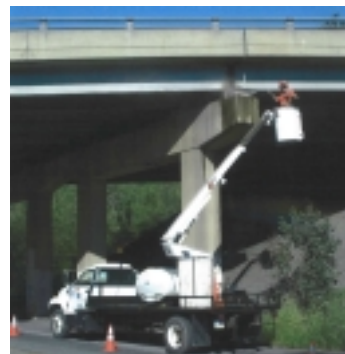
c) 専用車両を用いた洗浄 (ロードアイランド州)
