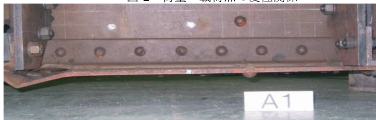
写真-1 実験によるフランジ A1 の変形
