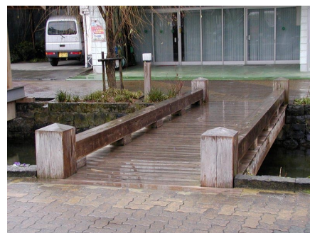
写真-1 小規模歩道橋の例
