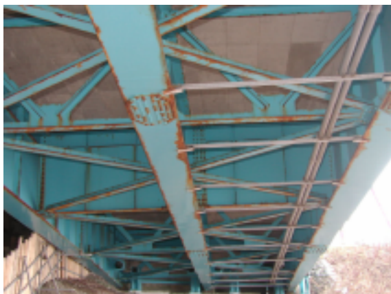
写真-1 A橋のWeb内側状況
