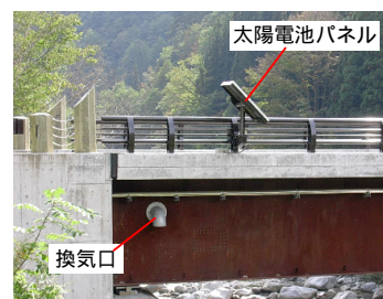
写真 - 1 換気システム設置状況
