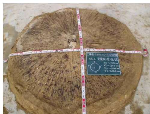
写真.2 免震層出来形全景
