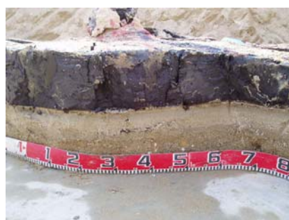
写真.3 免震層出来形断面
